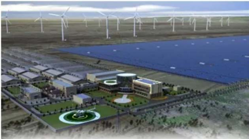
张北风光储示范项目
