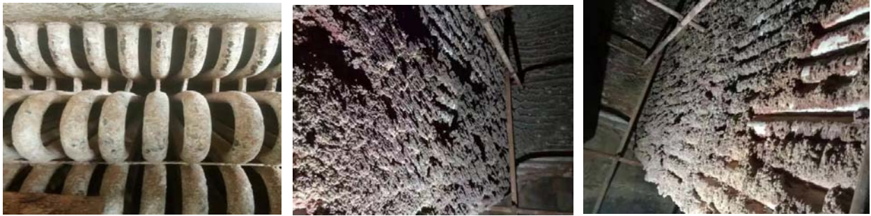
(水冷壁腐蚀图片)
